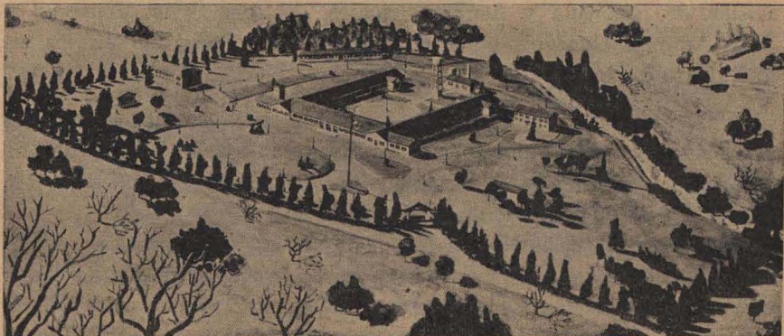
Obras en la Colonia de Vacaciones
