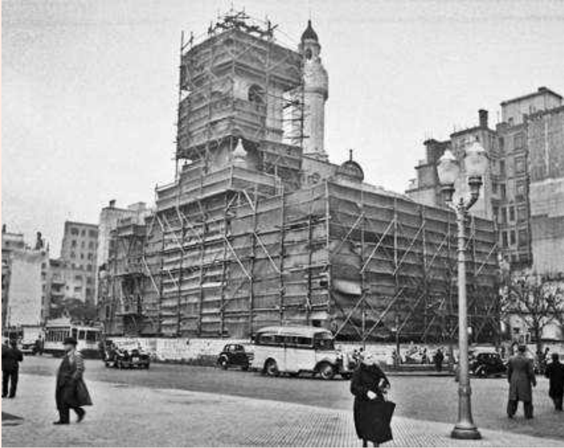
El Cabildo durante las obras de reconstrucción. Crédito foto: Legislatura de la Ciudad de Buenos Aires
