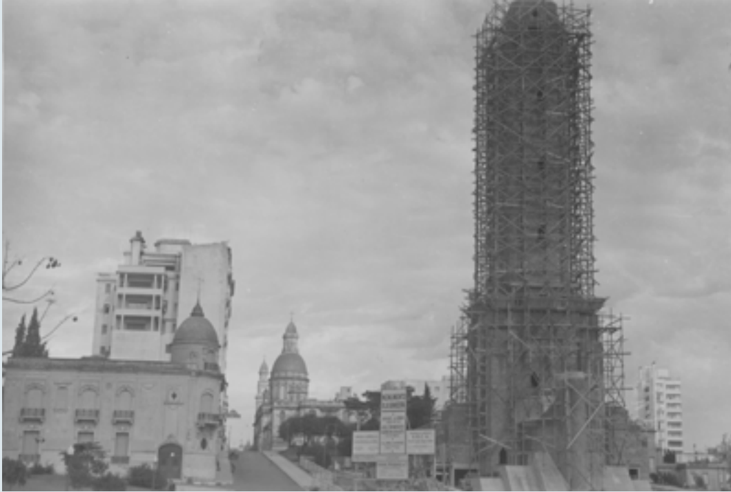
Monumento en construcción, ca. 1950. Crédito foto: Archivo General de la Nación
