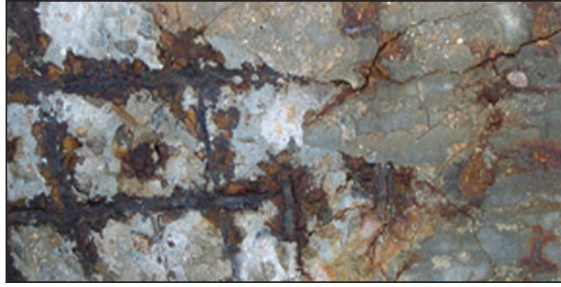
Figura 7.6. Efecto de la corrosión de las armaduras sobre diferentes estructuras de hormigón armado (izquierda, techo de una vivienda que ha sufrido carbonatación; derecha, pilares de una ornamentación sobre una costa marina).
