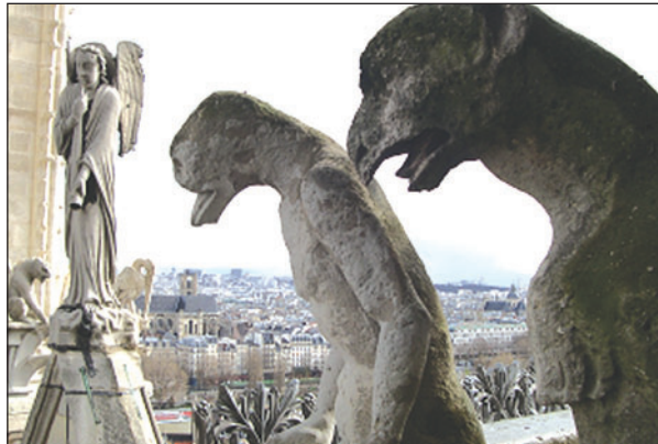
Figura 1.5. Degradación de la piedra (tipo particular de cerámico). Gárgolas en la Catedral de Notre Dame, París, Francia.
